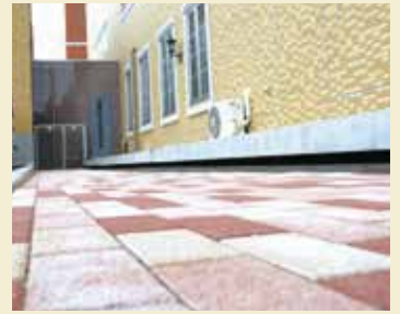
エキスパンション ジョイント部
