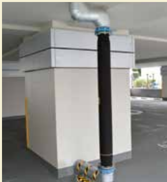
免震装置が組み込まれた柱
