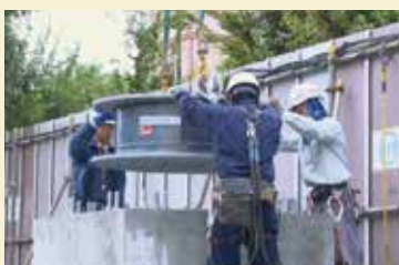
免震装置の据え付け
