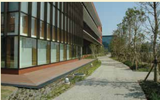
建物外周部に設けられたクリアランス
