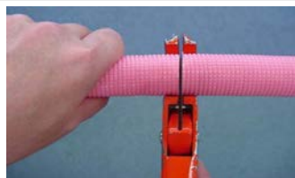
パイプを保温材ごと切断する
