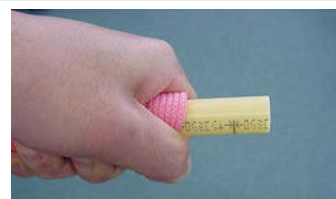
保温材をめくる。めくり難い場合は保温材融着部より手で割いて下さい
