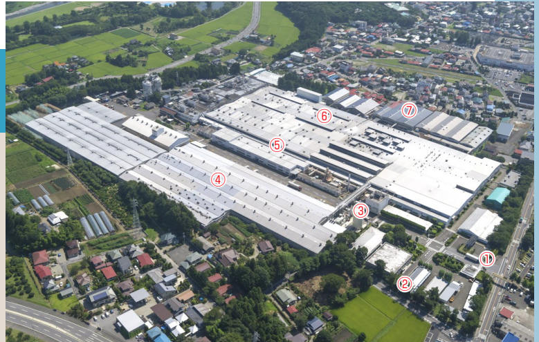
①正門 ②お客様センター ③コ・ジェネレーションシステム ④物流倉庫 ⑤西工場 ⑥工場本館 ⑦東工場
