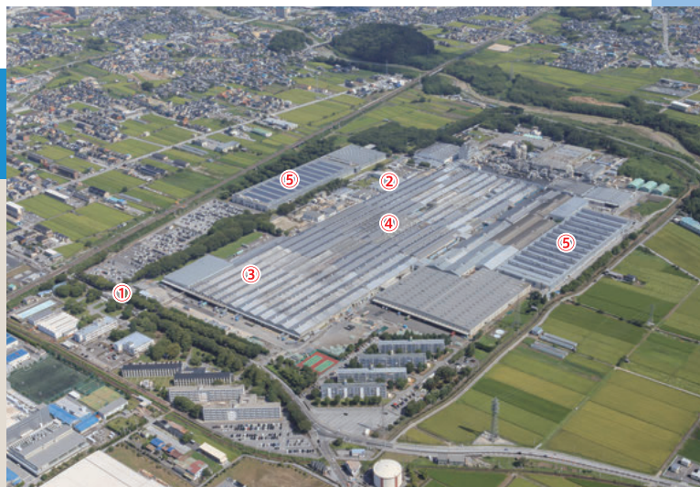
①正門 ②事務所 ③物流倉庫 ④タイヤ工場 ⑤太陽光パネル
