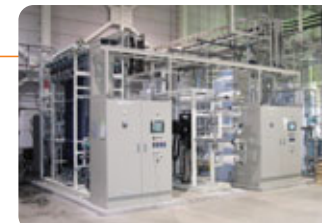
北九州工場における水の循環利用システム
