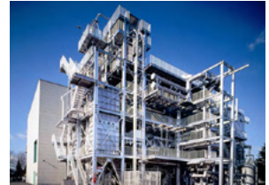
サーマルリサイクル 使用済みタイヤを有効利用して使用電力の一部を賅っています
