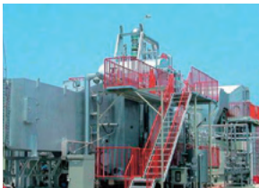
コージェネレーションシステム 発電時の排熱を有効に使うシステムを導入しています。
