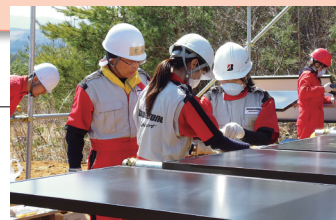
福島県いわき市でのボランティア活動（太陽光パネルの設置作業）
