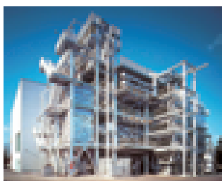
栃木工場焼却発電設備
