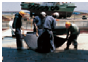
ケーソンマット施工の様子
