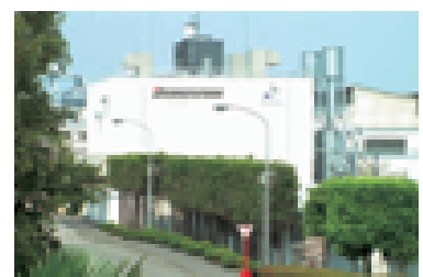
那須工場コ・ジェネレーションシステム
